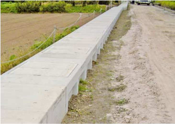
■片土圧による土留工法
