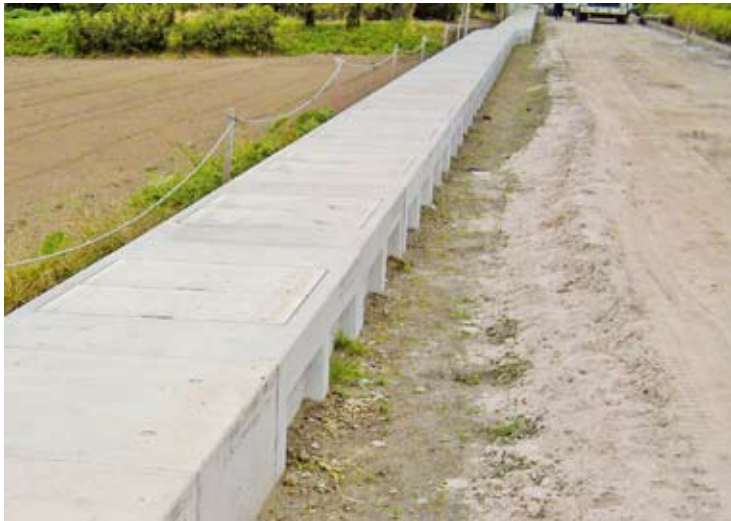
■片土圧による土留工法
