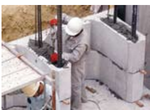
⑤ 縦貫コンクリート打設
