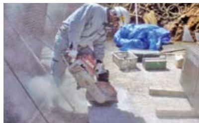
4.型枠パネル切断加工状況
