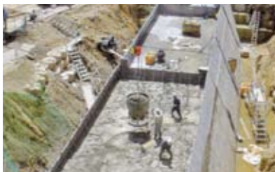
5.コンクリート打設状況
