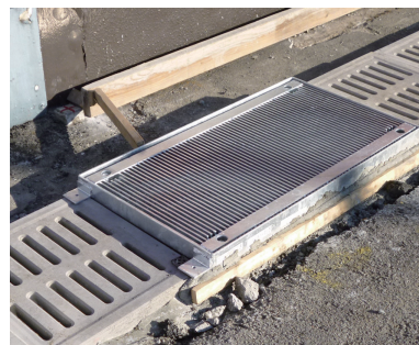
L=1000mmタイプ (L=500mmもございます) グレーチングは仮置のため裏返し状態になっています。
