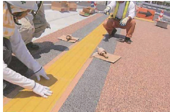
8. 通り(直線性)の確認
