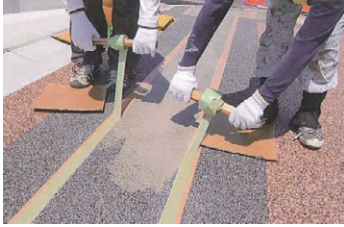
4. マスキングテープ(上部)を除去養生
