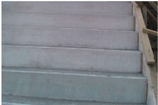
6.生コン打設完了
