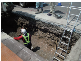
①掘削状況
