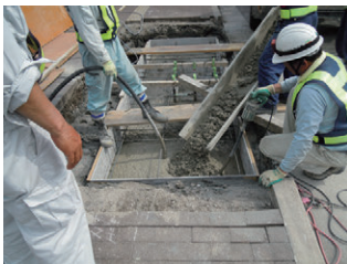
⑤生コン打設
