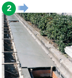
コンクリート打設
