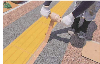
9. マスキングテープの除去 マスキングテープを取り除きます。接着剤が舗装面に垂れないように注意して巻き取ってください。
