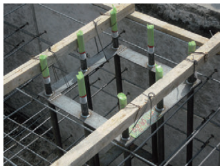
④アンカー筋設置
