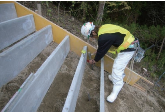
3.アンカー敷設
