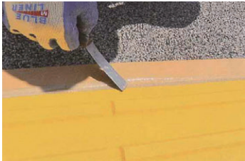
7. 点字タイル端部のテープ処理
