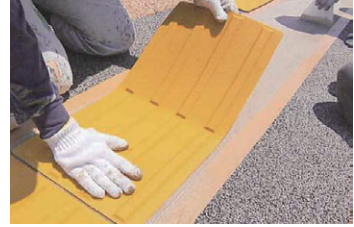
6. 点字タイルの貼付け
