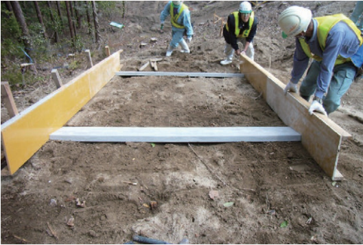
1.側面コンパネ設置
