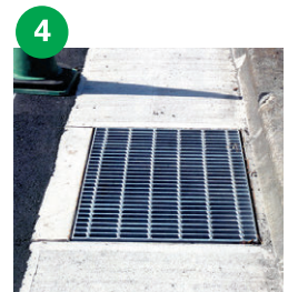
グレーチング設置
