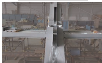
「マスマス整流ます」設置
