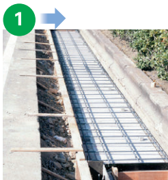
KCフォームの上に配筋した状態
