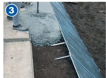
重ね合せ部に支承ゴムを貼り、左右の製品を10cm重ねて設置し(写真2参照)、下部は十字アンカー筋で、左右はボードファスナーで、天端は埋設プレートでそれぞれ固定します。
