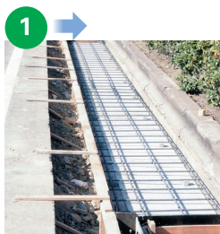
KCフォームの上に配筋した状態
