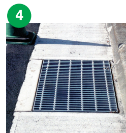
グレーチング設置
