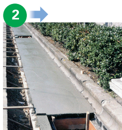
コンクリート打設
