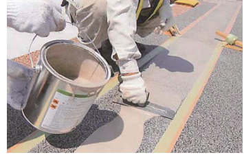
3. 専用接着剤の塗布・下塗り(シゴキ)
