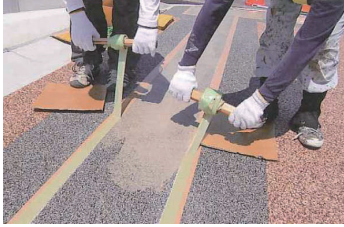
4. マスキングテープ(上部)を除去養生
