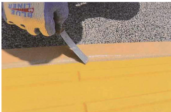
7. 点字タイル端部のテープ処理
