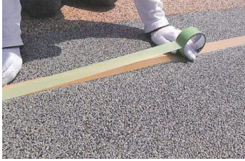
1. 墨出し清掃・マスキングテープ貼り(2重貼り)
