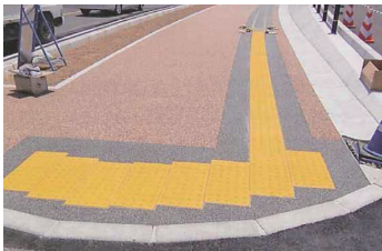
10. 完成(開放) 養生をとり、接着剤硬化を確認の上(冬期約90分 その他の季節約60分)解放します。
