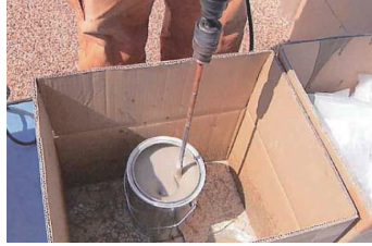
2. 専用接着剤の混合攪拌
