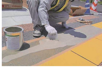
5. 専用接着剤の塗布・上塗り 2の手順で再度接着剤を混合攪拌し、専用のクシ目ゴテでムラなく均一に塗布します。
