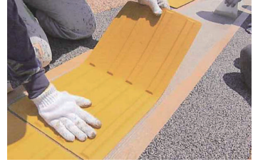
6. 点字タイルの貼付け
