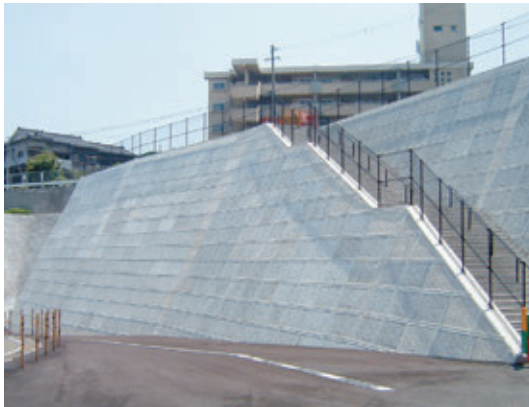
擬岩タイプ (階段積みもたれ式擁壁)
