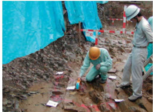
②地盤支持力確認
