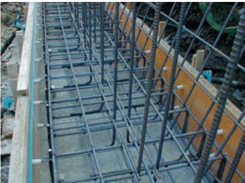
③底板部配筋
