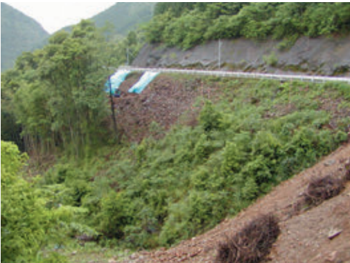
①工事着工前
