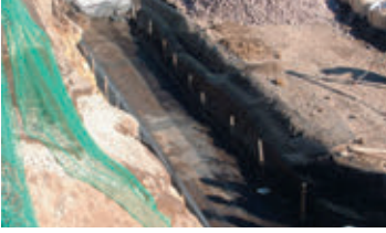
1.かごセンサー基礎敷設
