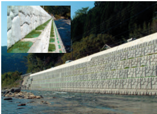
擬岩タイプ (階段積みもたれ式擁壁)
