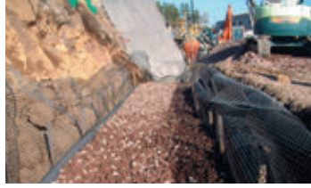
2.基礎単粒度砕石投入・かごセンサー連結
