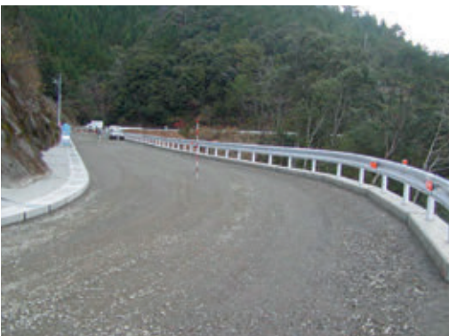
⑦完成直前天端部
