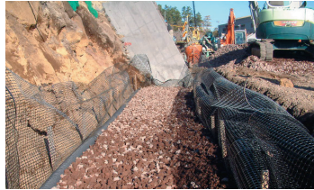
2. 基礎単粒度碎石投入・かごセンサー連結
