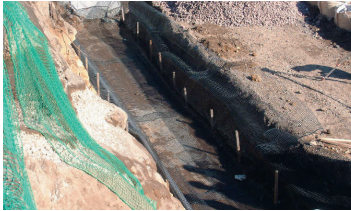
1. かごセンサー基礎敷設
