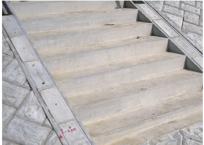
▲階段端部止工
