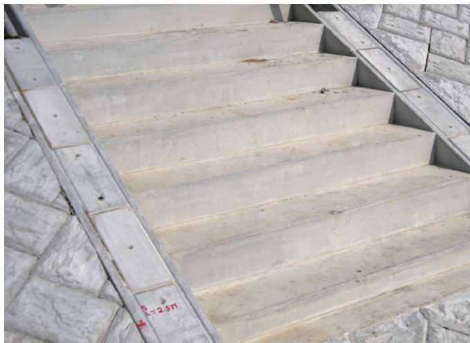
▲階段端部止工
