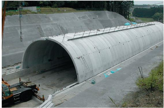
テクスパン工法は、アーチ構造物を3ヒンジで構築する工法です。短スパン橋梁や現場打ちカルバート・ボックスに代わるアーチ構造物として開発されました。コンクリート2次製品であるアーチ部材を、左右交互に組み立てることによりアーチを形成するため、迅速で安全に施工を行うことが可能です。したがって、立体交差化工事への適用においては、交通遮断を最小限に抑えることができます。また、水路トンネルに適用した場合は、アーチ部材は、側方からの架設が可能のため、河川を迂回させることなく施工できます。また、当社のテールアルメ（補強土壁）工法の技術を用いてウイング、頂部壁を設計しますので、土工量を最小限にし、トータルコストを削減します。
