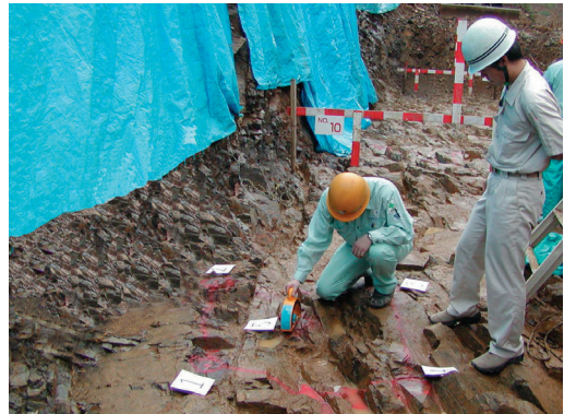
②地盤支持力確認
