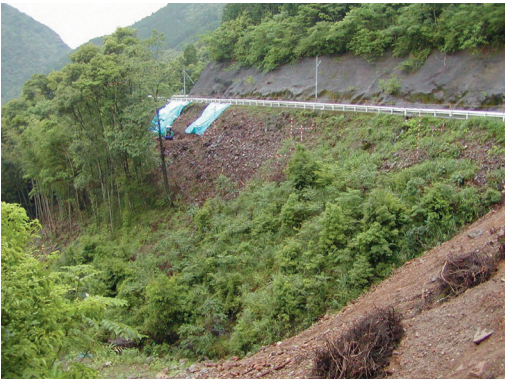
①工事着工前
