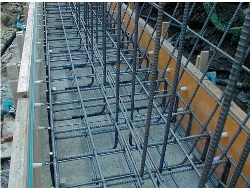
③底板部配筋
