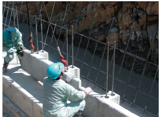
④フロントブロック敷設 (吊り金具の採用で施工が安全かつ早くなります。)
