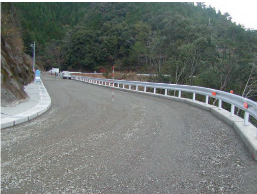
⑦完成直前天端部
