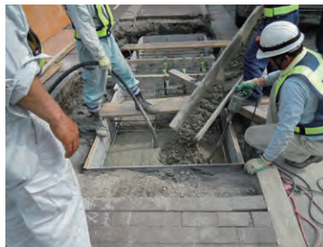
⑤生コン打設
