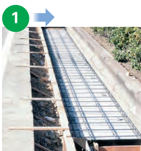
KCフォームの上に配筋した状態
