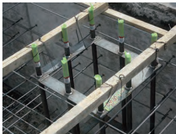
④アンカー筋設置
