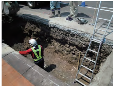
①掘削状況
