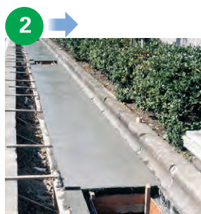
コンクリート打設
