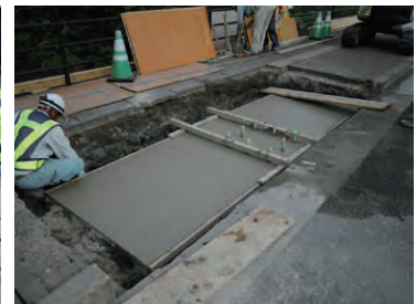
⑥仕上げ・養生
