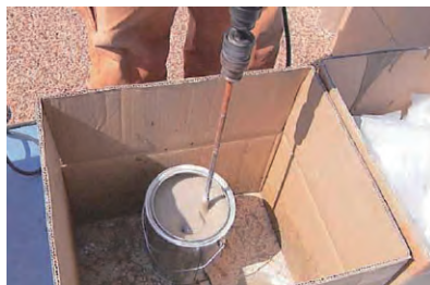
2. 専用接着剤の混合攪拌
