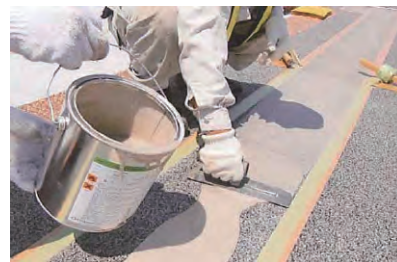
3. 専用接着剤の塗布・下塗り(シゴキ)
