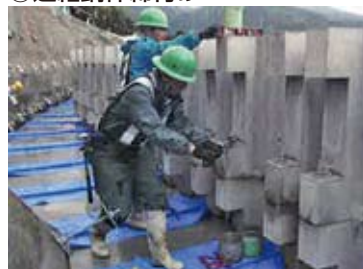
⑧連結鋼棒締付け
