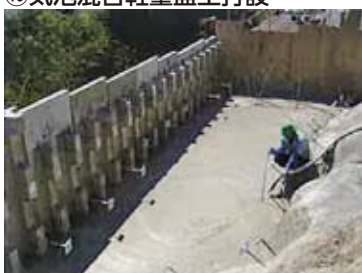
⑩気泡混合軽量盛土打設
