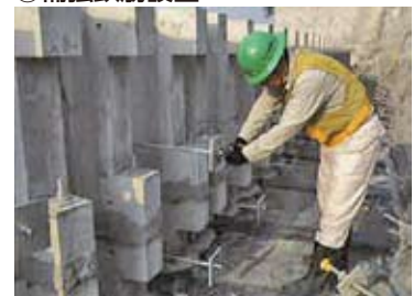
⑨補強鉄筋設置
