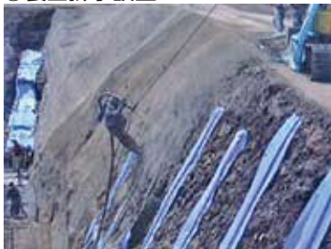
④カウンターアンカー打設
