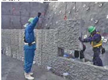
⑩気泡混合軽量盛土打設
