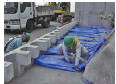
⑨補強鉄筋設置
