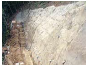
⑤基礎埋戻しコンクリート打設
