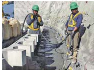
⑧連結鋼棒締付け
