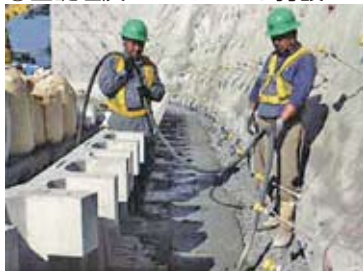
⑧連結鋼棒締付け
