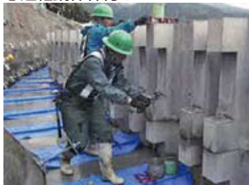
⑧連結鋼棒締付け
