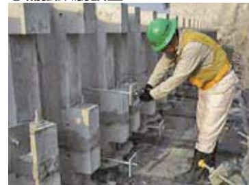
⑨補強鉄筋設置
