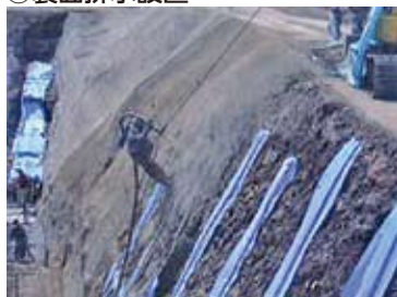
④カウンターアンカー打設
