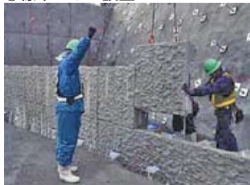
⑩気泡混合軽量盛土打設
