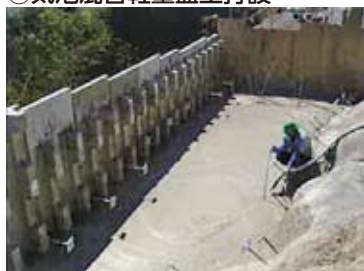
⑩気泡混合軽量盛土打設
