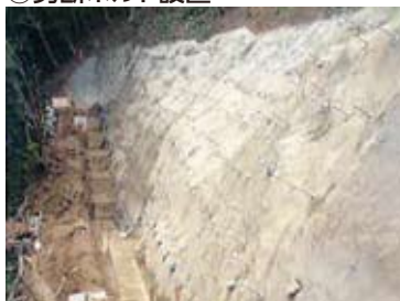
⑤基礎埋戻しコンクリート打設
