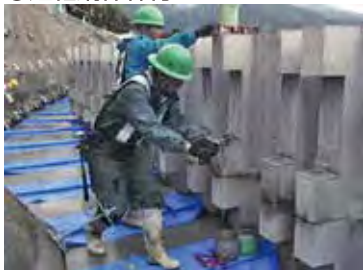
⑧連結鋼棒締付け
