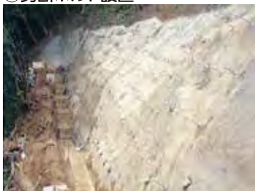
⑤基礎埋戻しコンクリート打設
