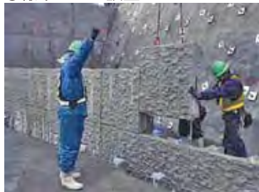
⑩気泡混合軽量盛土打設
