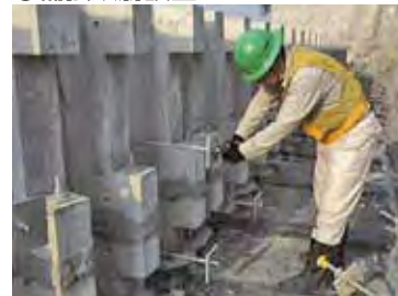
⑨補強鉄筋設置
