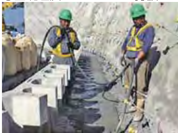
⑧連結鋼棒締付け
