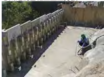
⑩気泡混合軽量盛土打設
