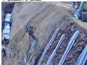
④カウンターアンカー打設
