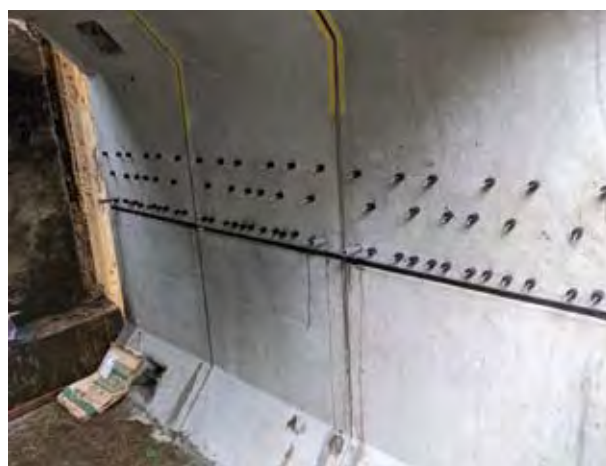
▲モルタル充填後
