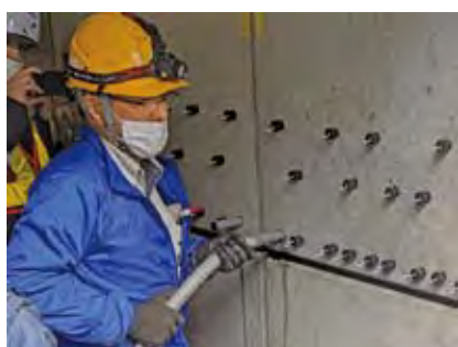
▲モルタル充填状況
