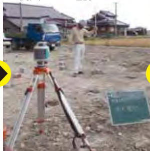
3: 杭天レベル確認
