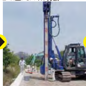
2: H型PCパイプ打設
