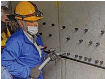
▲モルタル充填状況
