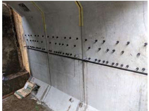
▲モルタル充填後
