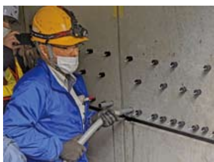
▲モルタル充填状況
