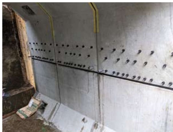
▲モルタル充填後
