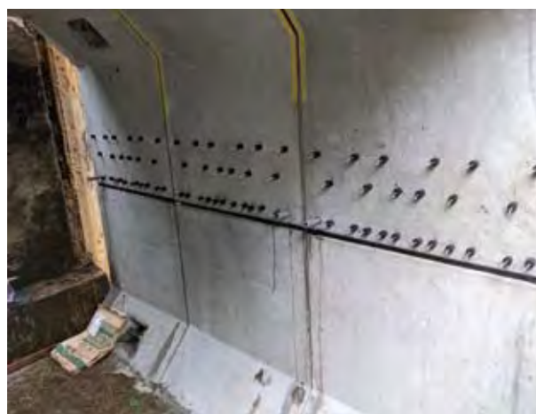
▲モルタル充填後
