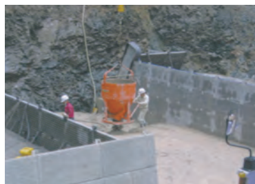
5.コンクリート打設状況
