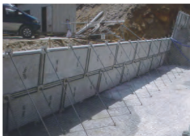
4.2段目設置完了状況
