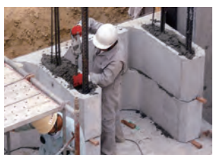
⑤ 縦貫コンクリート打設
