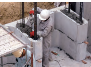
⑤ 縦貫コンクリート打設
