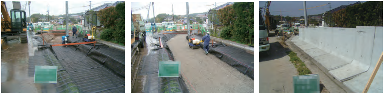
▲L型擁壁の基礎地盤補強の採用事例。農耕地に隣接しているため、コンクリートによる地盤改良が行えず、周囲の環境に影響を与えないジオグリッドを用いた「マットレス工法」が採用になりました。
