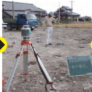
3: 杭天レベル確認
