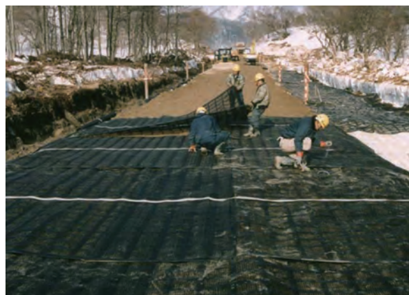
▲軟弱地盤において不同沈下を防ぐ
