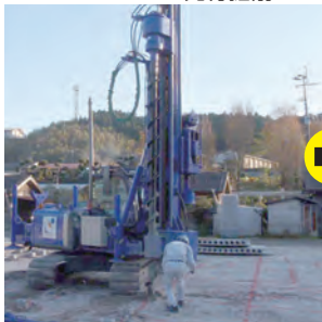
1: オーガーによる先行掘削
