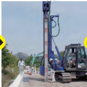
2:H型PCパイル打設
