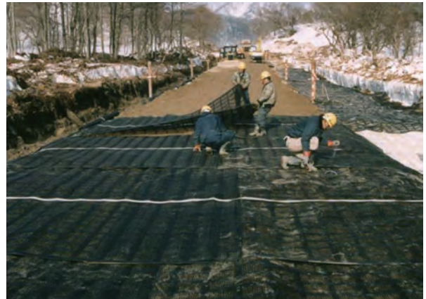
▲軟弱地盤において不同沈下を防ぐ
