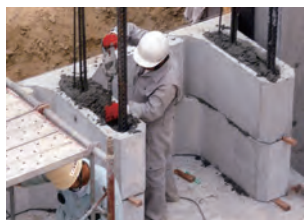
⑤ 縦貫コンクリート打設
