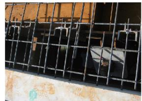
前後の調整は、製品からのアンカー筋(先端ネジ切)で調整を行います。上下方向は、固定部溝のある鋼材を上下にスライドさせ六角ボルトを用いて固定することで調整します。
