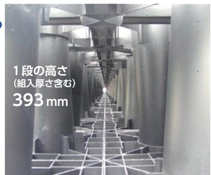
貯留槽内部の構造
