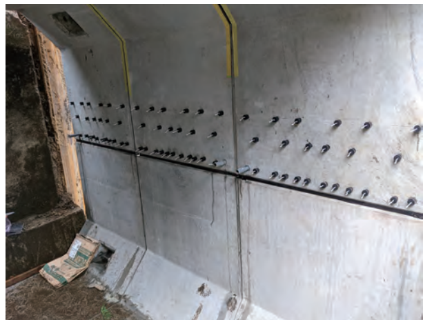
▲モルタル充填後
