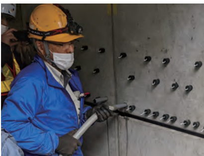
▲モルタル充填状況
