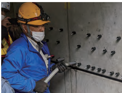
▲モルタル充填状況
