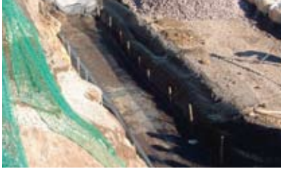
1.かごセンサー基礎敷設
