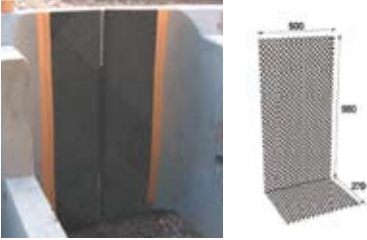
4.耐震性壁体目地材(ネトロンシート)
