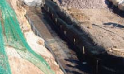
1.かごテンサー基礎敷設
