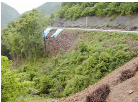
①工事着工前
