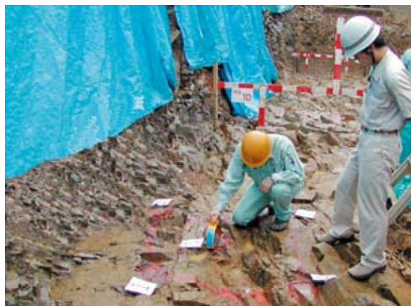
②地盤支持力確認
