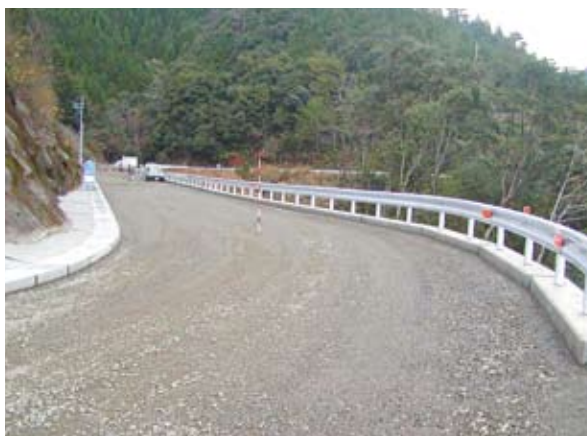
⑦完成直前天端部
