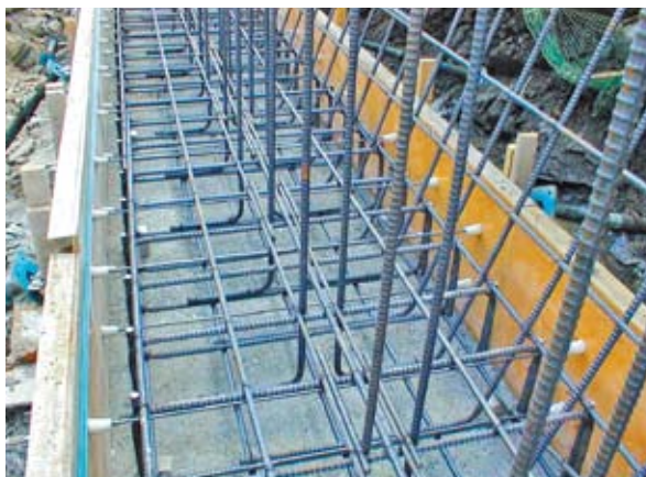
③底板部配筋
