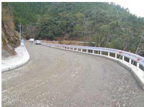
⑦完成直前天端部
