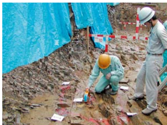
②地盤支持力確認
