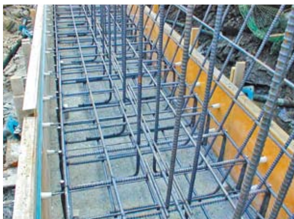
③底板部配筋
