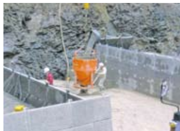
5.コンクリート打設状況
