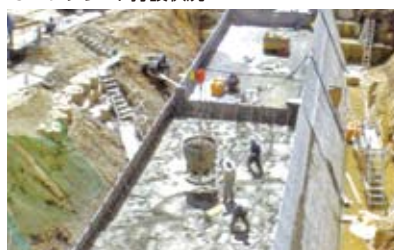
5.コンクリート打設状況
