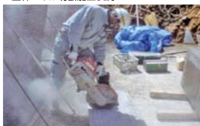
4.型枠パネル切断加工状況
