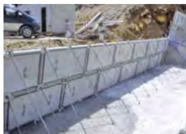
4.2段目設置完了状況
