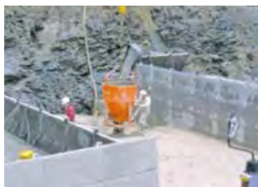
5.コンクリート打設状況
