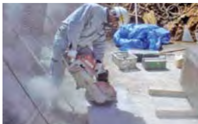
4.型枠パネル切断加工状況
