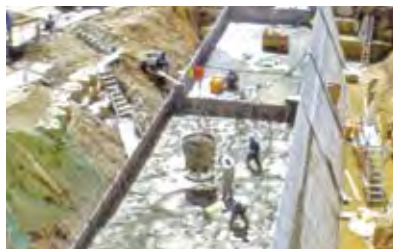
5.コンクリート打設状況
