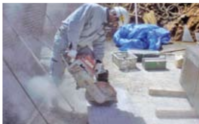
4. 型枠パネル切断加工状況
