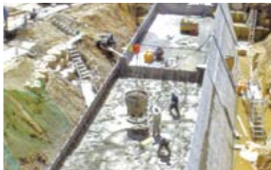
5.コンクリート打設状況
