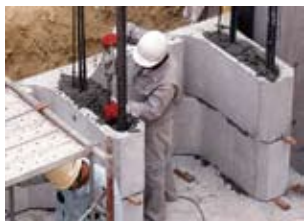
⑤ 縦貫コンクリート打設
