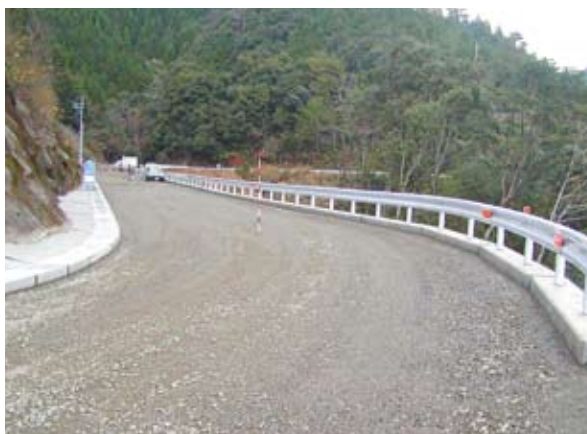
⑦完成直前天端部
