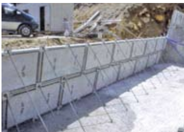
4.2段目設置完了状況
