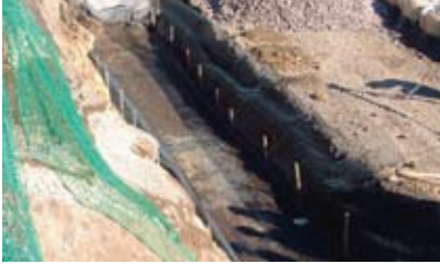
1.かごテンサー基礎敷設
