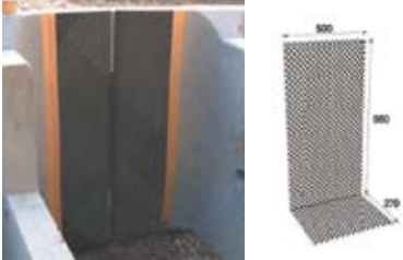
4.耐震性壁体目地材(ネトロンシート)
