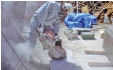
4.型枠パネル切断加工状況
