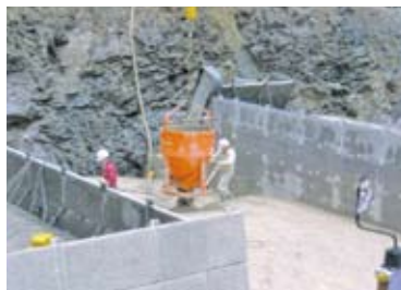
5.コンクリート打設状況
