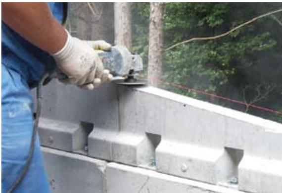
5.カサロック同士、カサロックとL型擁壁の接合部(背面側)に付属の止水テープを貼り、ボルト部をモルタルで埋めます。
