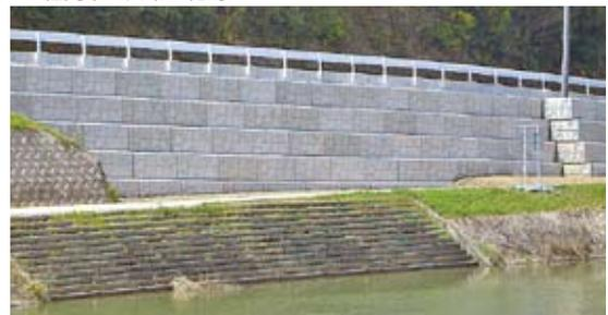
箱型擁壁は、箱体と壁体材(単粒度碎石)で構成されており、特別な排水装置を備えなくても極めて排水性が高いのが特長です。湖沼、ダムなどの水際。水中部材として使用する場合は、通水性が良いため、単粒度碎石による隙間水質浄化効果があります。さらに水際生物の生棲にとっては、小段部の自然植生・陸上への始動がしやすいなど、比較的大きな生態系保全空間をえられます。
