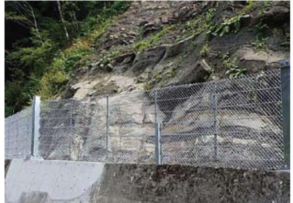
■一般構造図例 再強フェンス®Lタイプは、支柱、ワイヤロープ、金網、支柱基部アンカーで構成されています。支柱の基部を既設の擁壁にアンカーで固定して、延長方向にワイヤロープと金網を張設します。
