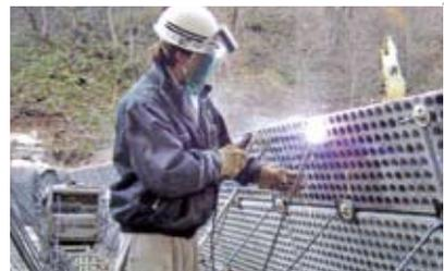
4.型枠パネル切断加工状況
