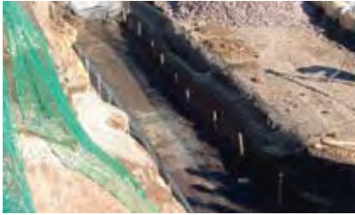
1.かごテンサー基礎敷設
