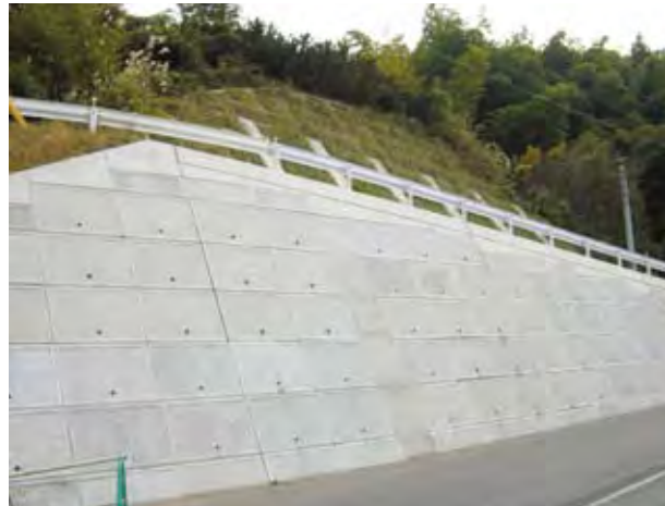
福岡県八女市:標準ブロック(かさね積みもたれ式擁壁)
