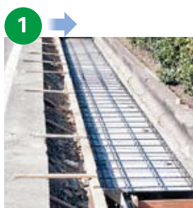
KCフォームの上に配筋した状態
