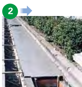
コンクリート打設
