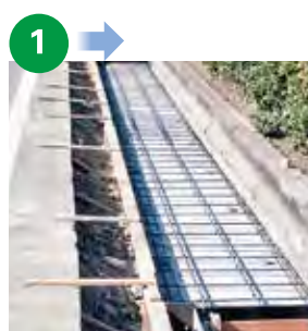
KCフォームの上に配筋した状態
