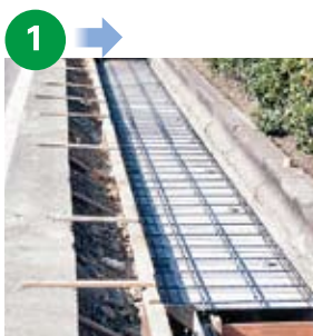
KCフォームの上に配筋した状態
