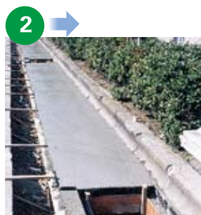
コンクリート打設
