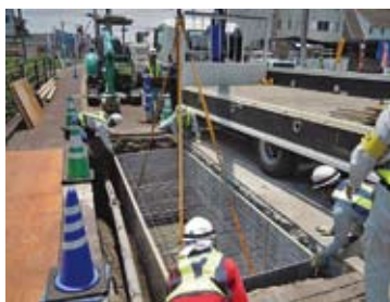
②KCスタンドフォーム据付け
