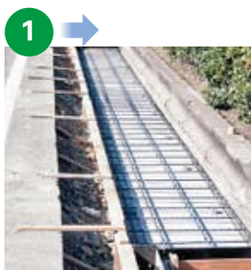
KCフォームの上に配筋した状態
