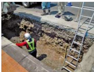
①掘削後敷砂
