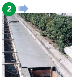
コンクリート打設
