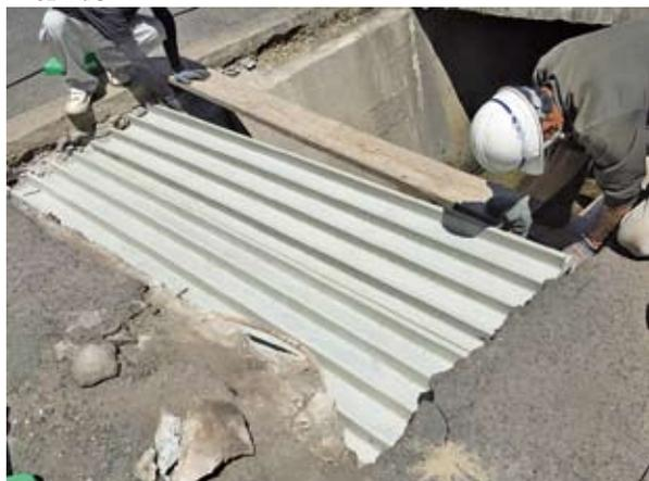
※コンクリート打設時の側圧でたわまないように製品にはキャンバー(緊張力による反り)がついています。
