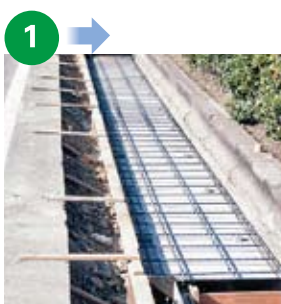
KCフォームの上に配筋した状態
