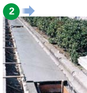
コンクリート打設
